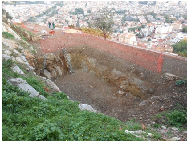
FOTO 19. Dipòsit excavat a la zona E2
