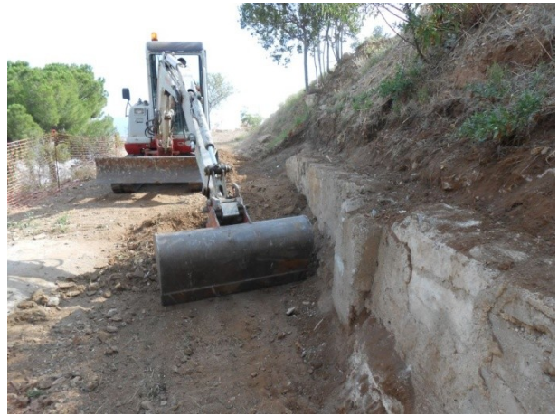
FOTO 14. Descalçat dels murs M3 de la zona E1
