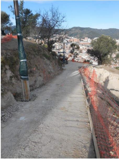
FOTO 33. Estat final del camí carrer del Turó de la Rovira – Dormitoris de la tropa
