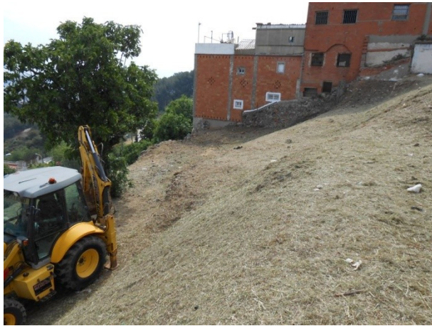
FOTO 17. Estat inicial de la zona E2
